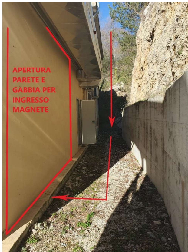
Foto n° 13 e n° 14 sollevamento e introduzione della RM nel vano esterno e apertura varco sala RM
