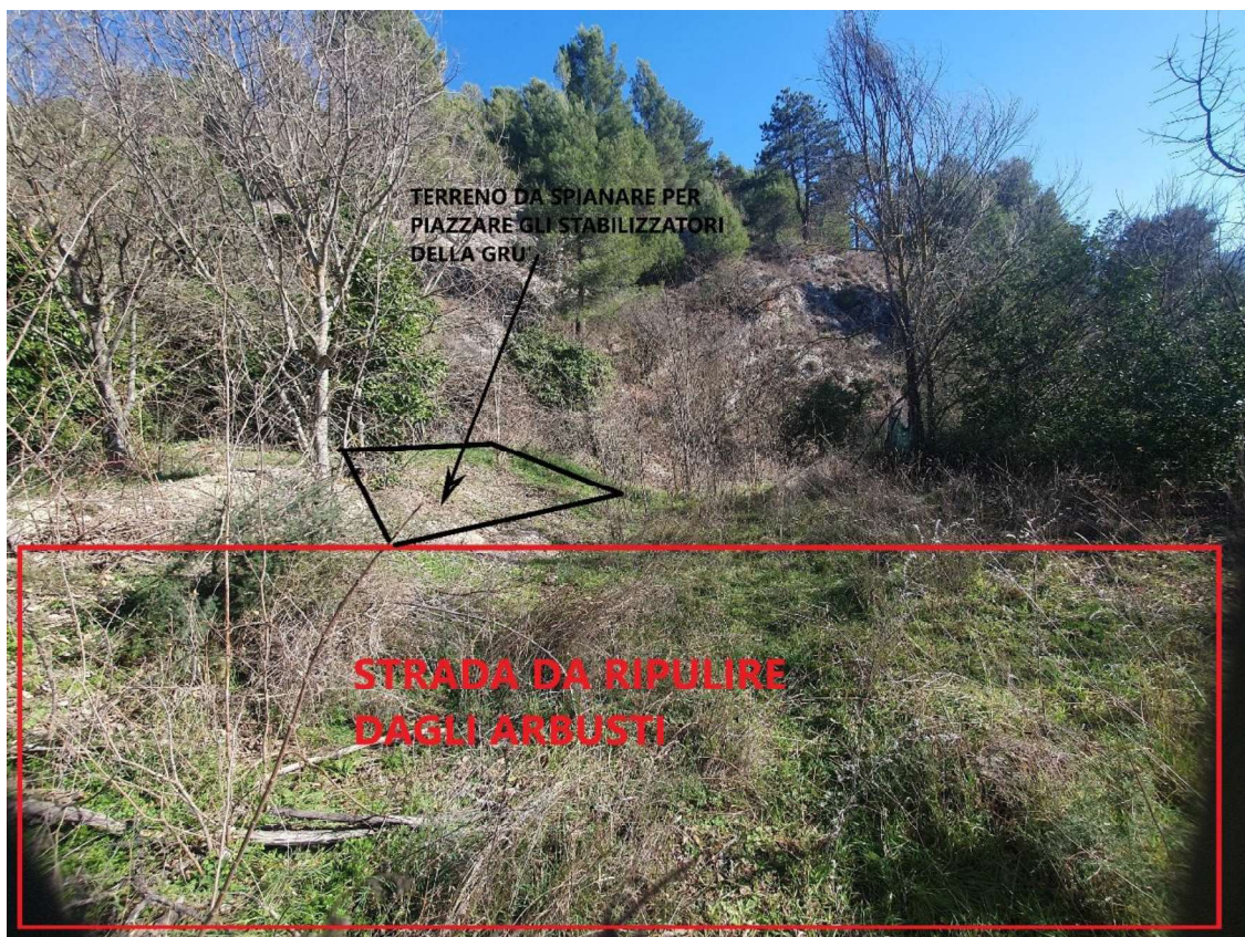
Foto n° 8 Posizionamento autogrù con terreno da spianare per gli stabilizzatori
